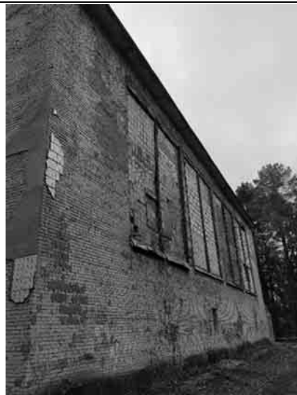
Фото №4: Внешний вид здания
