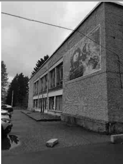
Фото №1: Внешний вид здания (главный вход)
