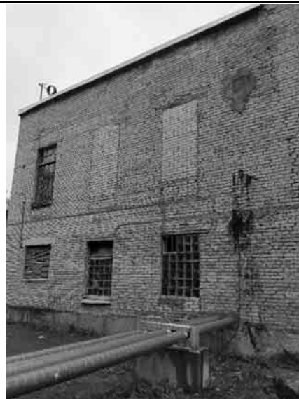
Фото №2: Внешний вид здания
