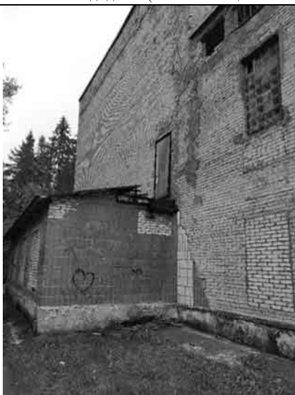
Фото №5: Внешний вид здания
