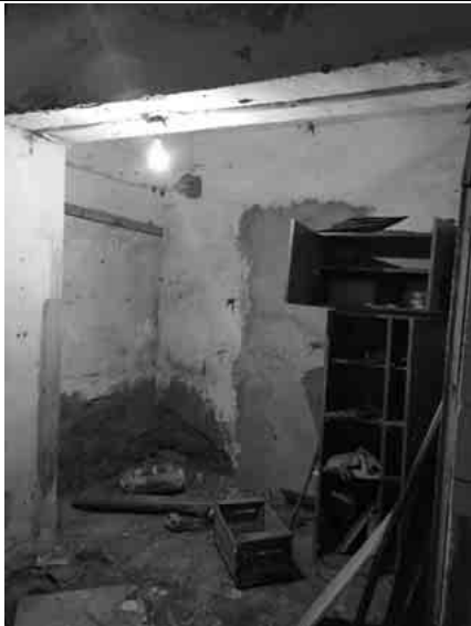
Фото №21: Хоз. помещение
